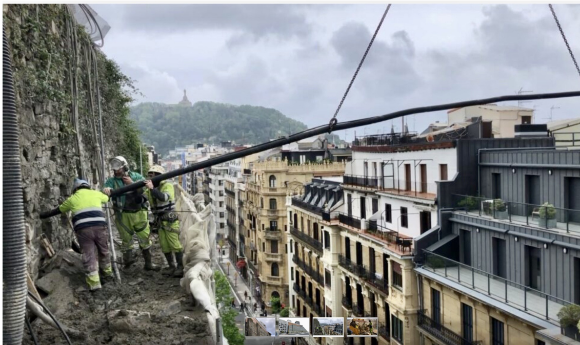
Imagen 18 – Foto de la obra de estabilización y limpieza de una parte del Muro en 2019; se aprecia uno de los pasillos retranqueados que tiene el Muro para colocar jardineras.
