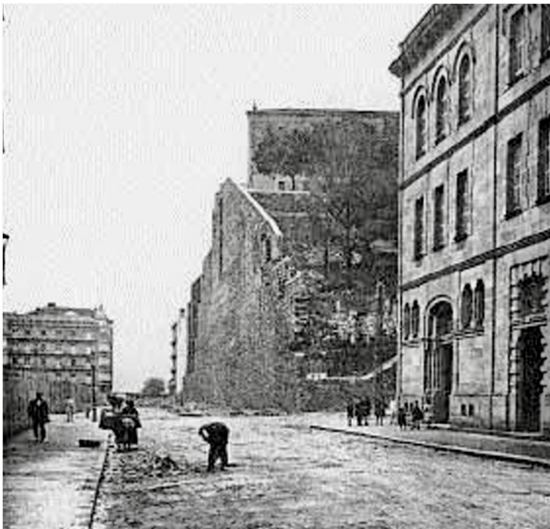
Imagen 16 – Foto del Muro de piedra arenisca de la calle Easo, construido en 1914.
